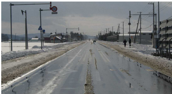
湿潤、凍結した道路
